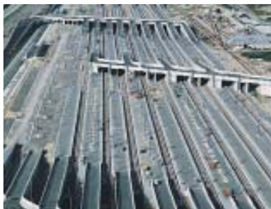
Terminal del túnel del canal, RU
