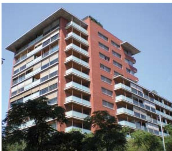
Edificio en la zona de Sarriá, Barcelona. Fachada de ladrillo soportada mediante HK4 y el atado de la fábrica mediante perfiles HTA y llaves.
