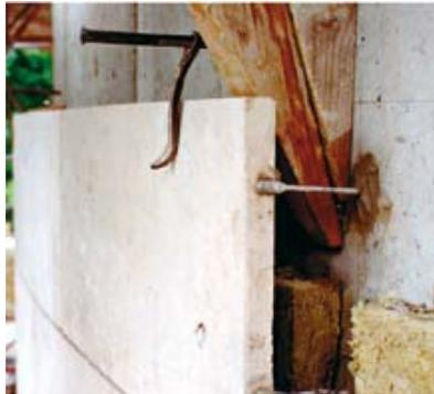
Las placas se fijan por lo general en 4 puntos. Antes de taladrar el agujero de fijación, recortar huecos suficientemente grandes en el aislamiento.
